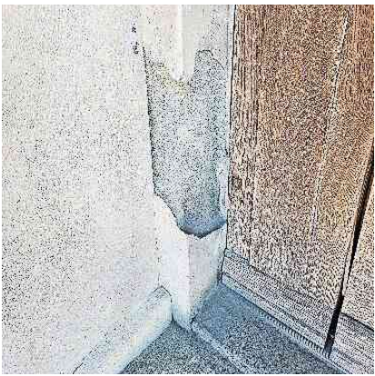
Witterungsschäden
