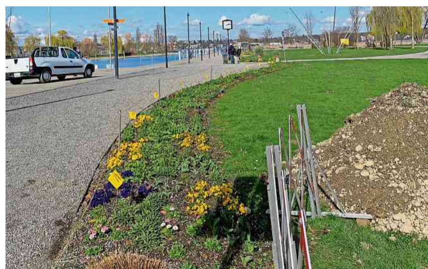
Vom Minigolf bis zum Wartehäuschen schlängelt sich das neue Bewässerungssystem durch die Blumenrabatte.
