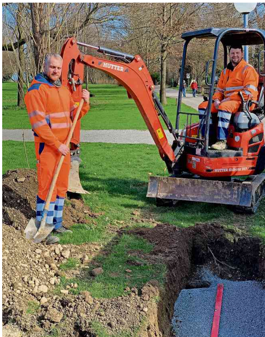
Konrad Babirat (links) und Leonardo Batista heben einen Graben für den Wasser- und Elektroanschluss aus.
